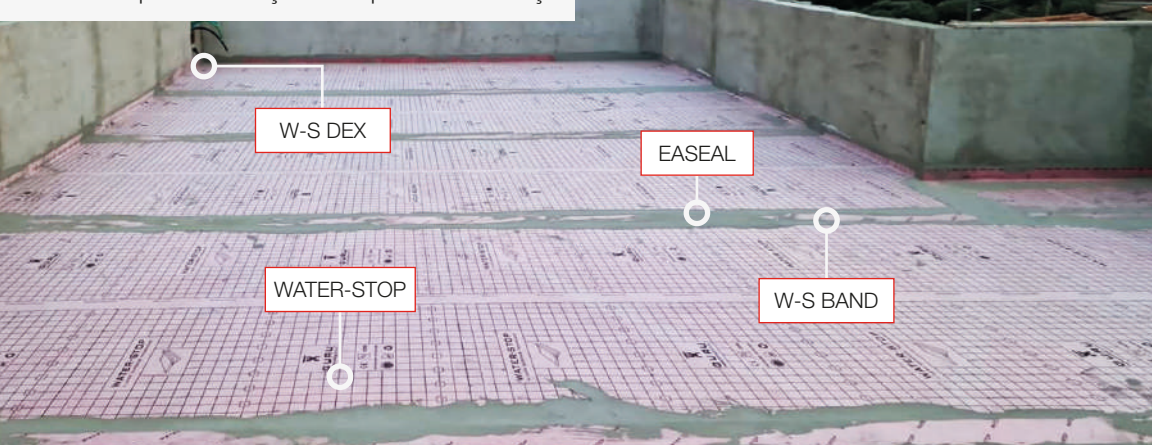
Impermeabilização de capa fina em terraço
